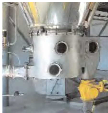
Рис. 6. Флюїдне днище двоступеневої сушарки А1-ОР2С для сушіння молока (Калинівський машзавод, Україна)
